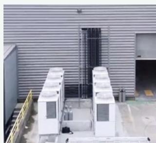
STEMCELL Technologies, una empresa mundial de biotecnología, instaló unidades de condensación CO<sub>2</sub> para las cámaras de frío de su almacén. Francia. **Refrigeración**
